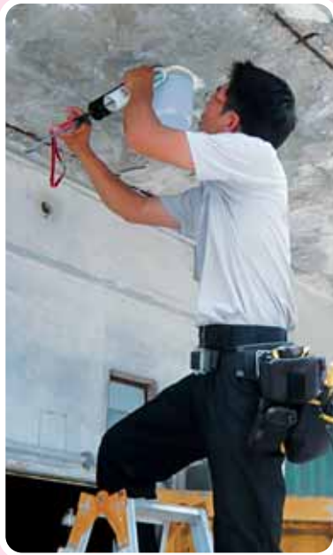
▲電気の不良箇所の改修作業中
