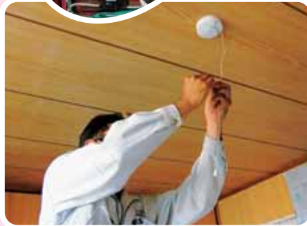
▲火災報知器の設置作業中
